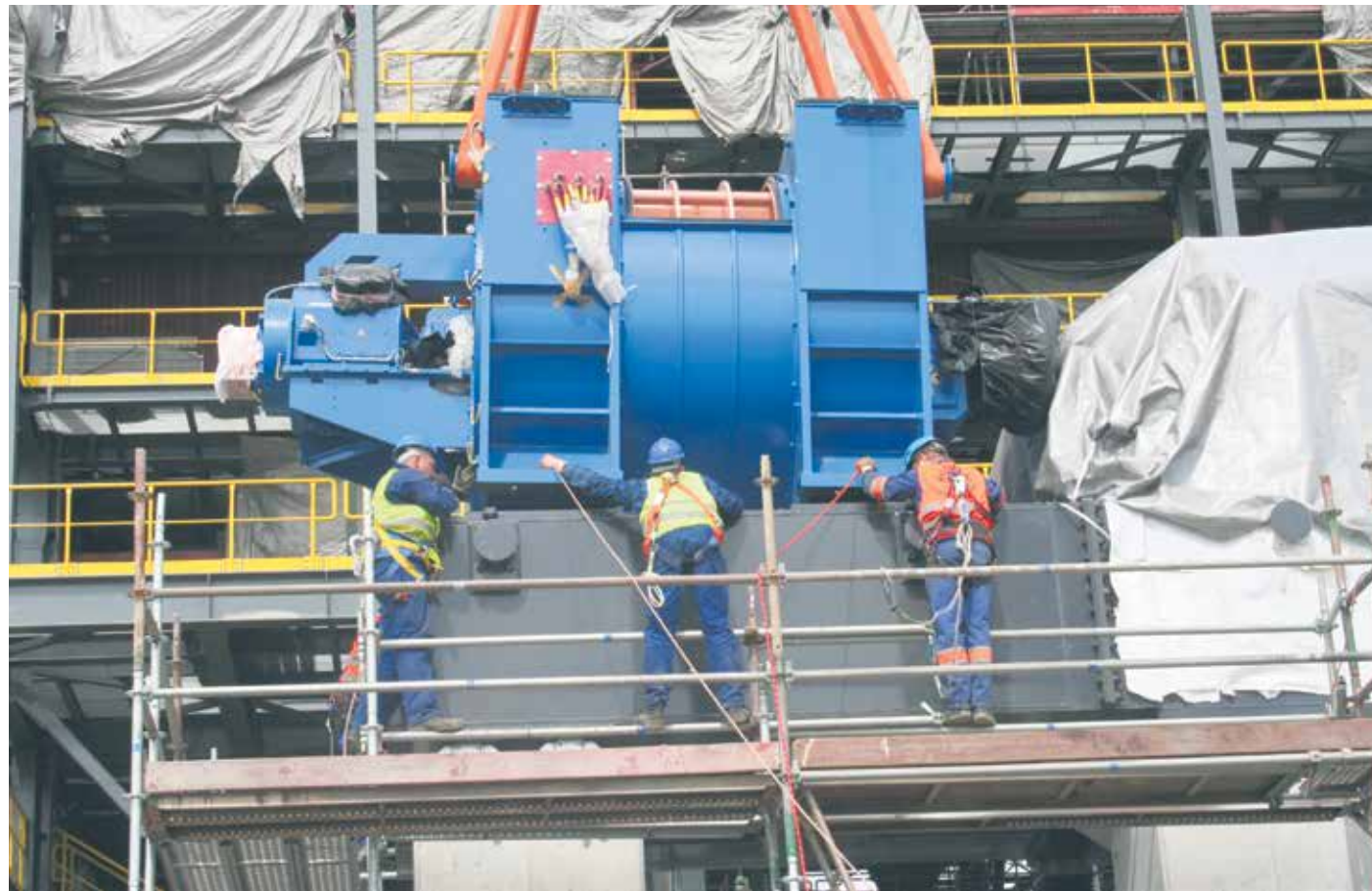
Turbozespół EcoGeneratora powstał w czeskim Brnie. Jego producentem jest firma EKO. Na zdjęciu: montaż turbiny.
