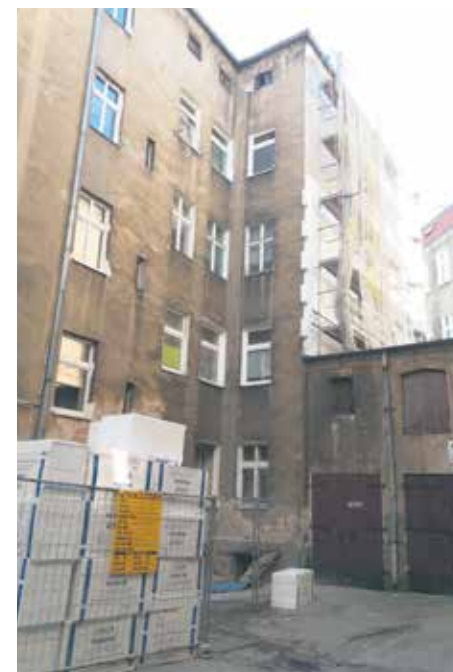
Rozpoczęły się prace związane m.in. z ociepleniem i termomodernizacją oficyny kamienicy przy ul. Mazurskiej 44.
