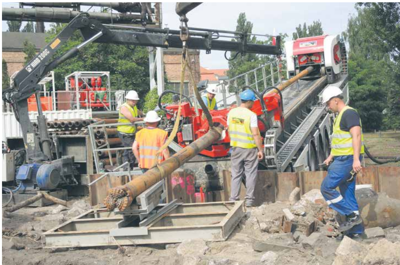
Szczeciński Park Przemysłowy, 30 czerwca, wiertnica tuż przed rozpoczęciem przewiertu
